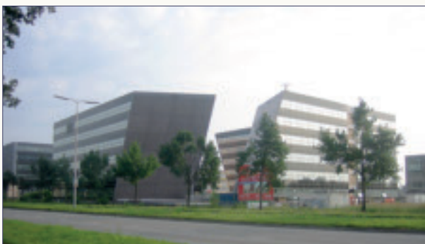
Het kantorencomplex Place Vendôme in Zwolle.
